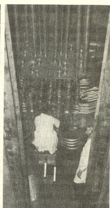
Widok „zimnego” i „niezatopionego” rdzenia reaktora Maria przez służę z komory do przeładunku pretów paliwowych
