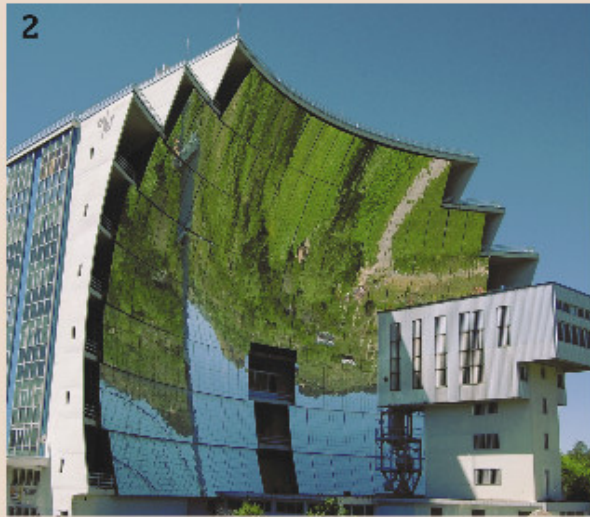
Piec słoneczny w Odeillo (Francja), wym. 54x48 m. moc 1 MW. Lustra na zboczu sąsiedniego wzgórza kierują do niego promienie słoneczne.
